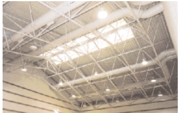
FOTO 7. Cubierta de sala de ensayo.
