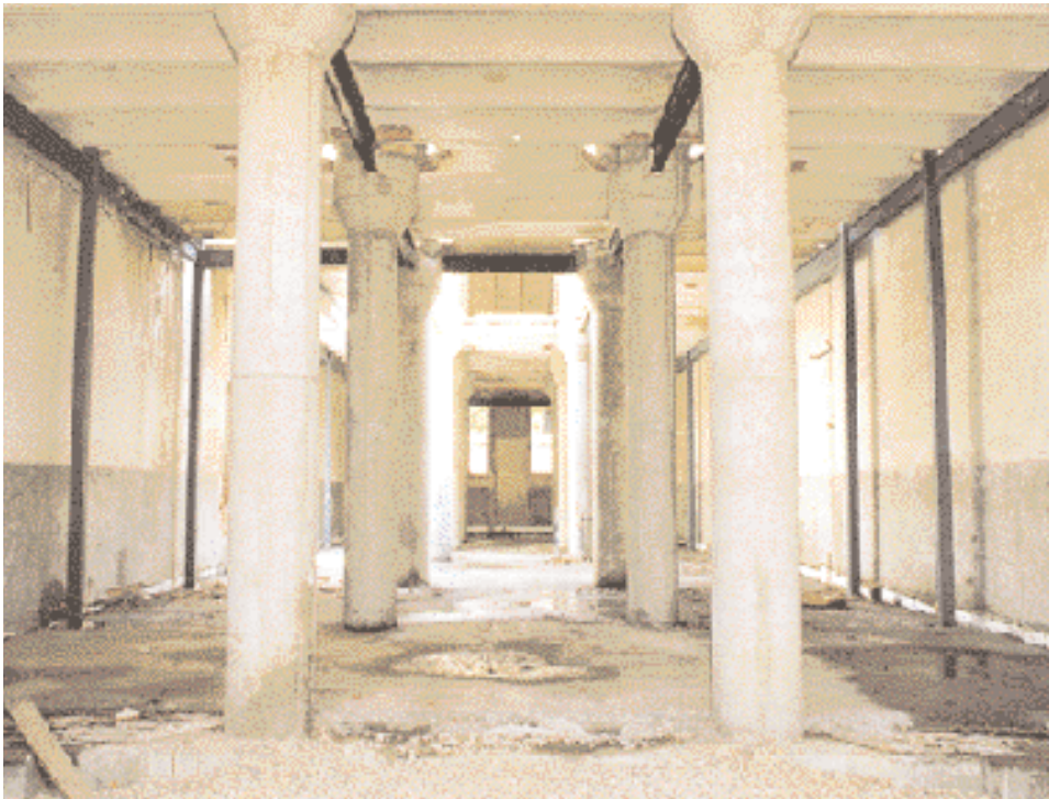
FOTO 5. Estructura de nave tipo.
