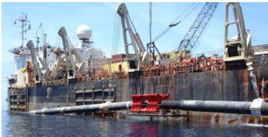
Extracción de los dos extremos de tubería y unión
