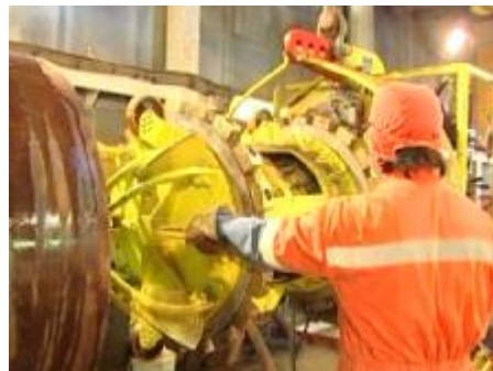
Biselado de las juntas de los tubos
