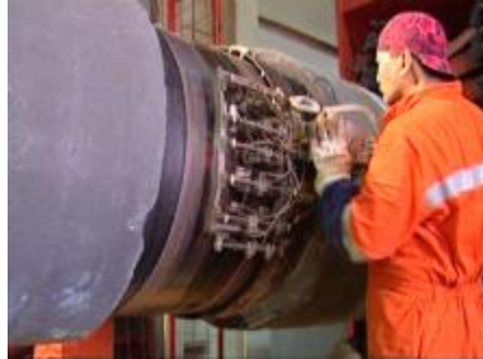
Control de la soldadura mediante ultrasonidos
