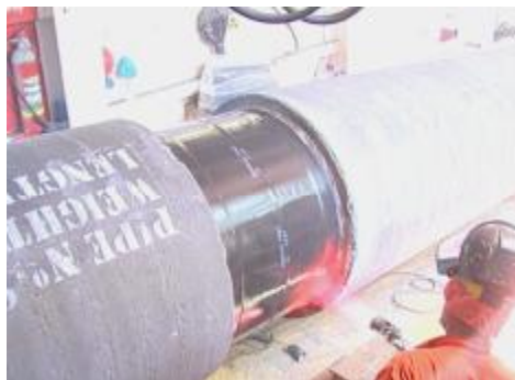
Colocación del manguito de polietileno termorretráctil
