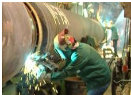
Soldadura a tope de las juntas
