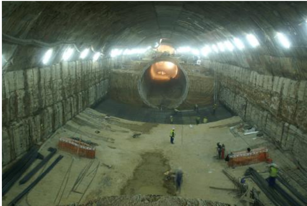
Figura nº 16. Ejecución de la contrabóveda
