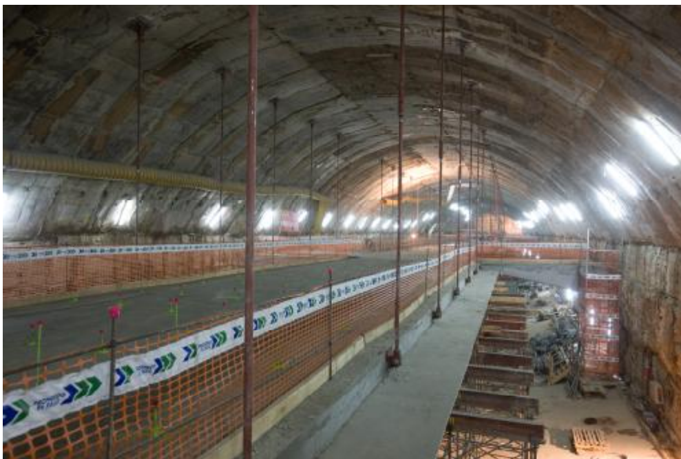
Figura nº 17. Ejecución de la Mezanina
